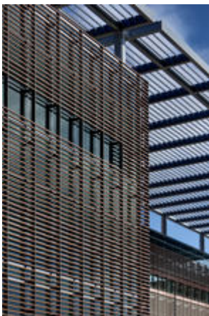
Terra cotta brise soleil.
